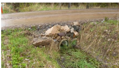
propustek - pohled z LB
