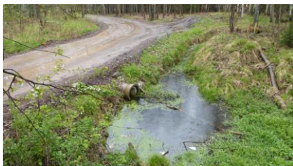
propustek O09 - pohled z LB
