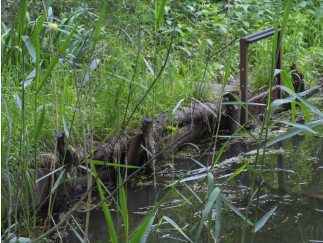
Hrás s česlem na hranici plochy I. a III. zadržující vodu v Tonicí
